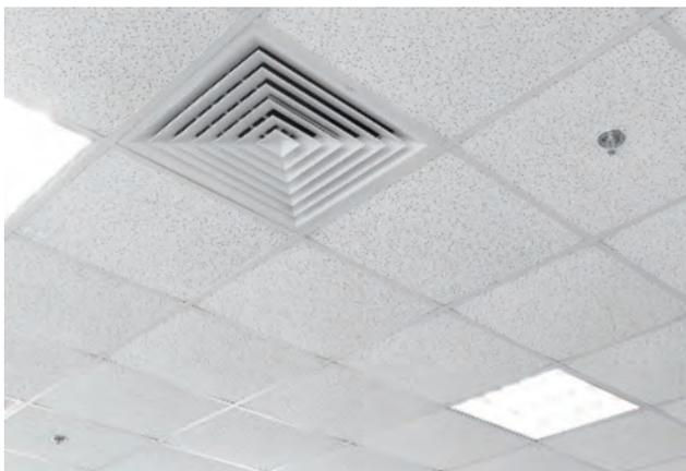
圖 4 安裝在封閉吊頂上的方形散流器
