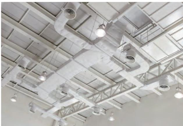
圖 3 安裝在開放式天花板上的圓形散流器
