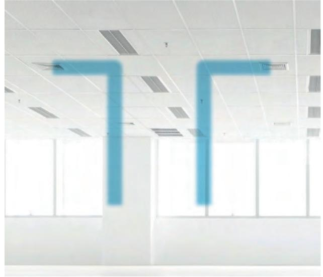
圖 1 A 和 1B 基於速度為 50fpm (0.25m/s) 指向散流器之間中點的等溫射流，ADPI 有助於舒適性設計。與回流和平行流型不同，ADPI 大於等於 80% 表示空間內充分混合，如果 ADPI 小於 80%，那麼裡面的人員會感到不舒服而投訴。上圖中，左面展示了較佳的 ADPI，右面表示 ADPI 不佳 WR36/Shutterstock
