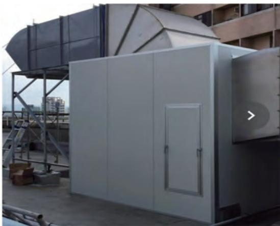
圖八、頂樓排油煙機的隔音處理
